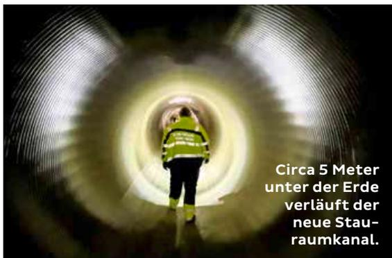
Circa 5 Meter unter der Erde verläuft der neue Stauraumkanal.
